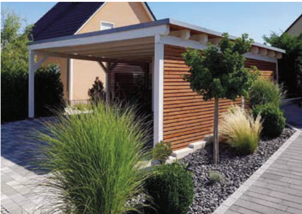
Abb. 4 Beispiel Stellplatz mit Carport © SAENA
