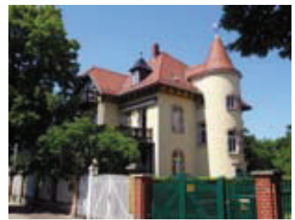
Abb. 3 Beispiel für sanierte Villa
