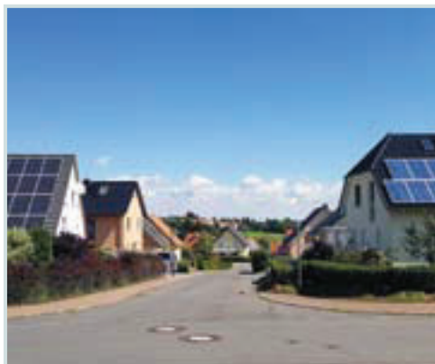
Abb. 8 EFH mit PV-Anlage
