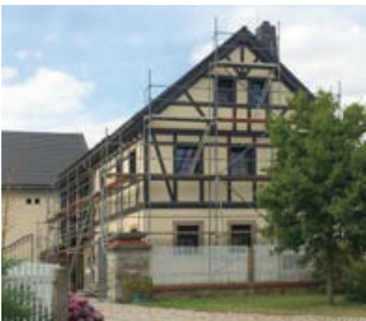
Abb. 10 Beispiel für Fachwerkhauassanierung
