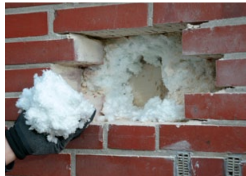
Abb. 44 Eingeblasener mineralischer Dämmstoff in einem zweischaligen Mauerwerk
