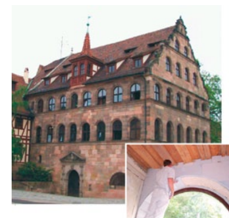
Abb. 61 Innendämmung der Fassade eines denkmalgeschützten Gebäudes
