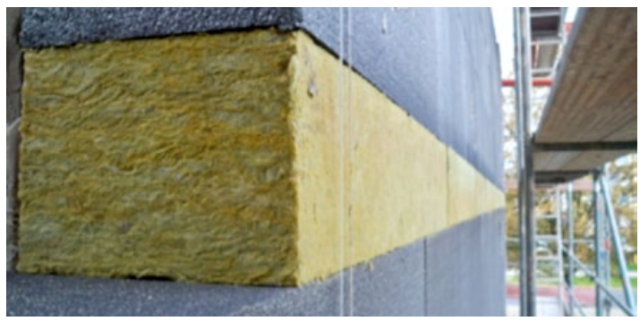
Abb. 7 Brandriegel aus Mineralwolle
