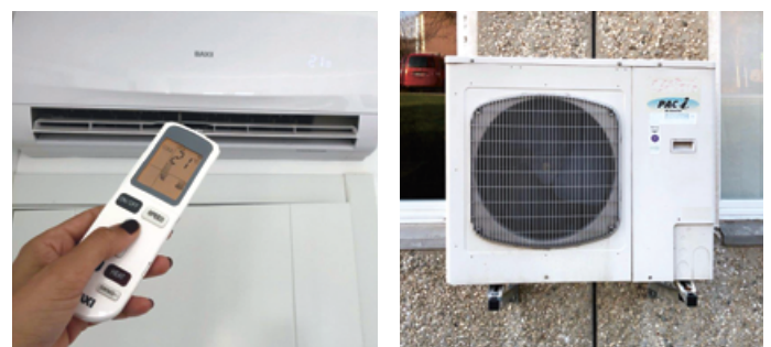
Abbildung 8: Links: Inneneinheit zur aktiven Kühlung von Innenräumen. Rechts: Zugehörige Rückkühltechnik (Außeneinheit) an einer Gebäudefassade.
