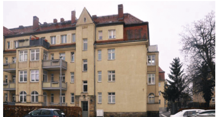
Abbildung 13: Ansicht der Fassaden Süd (oben) und Nord (unten) des Beispielobjektes.
