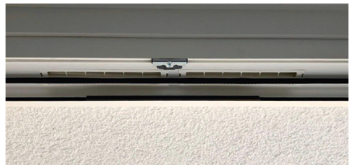
Abbildung 7: Oben: Schematische Darstellung einer zentralen Abluftanlage im Gebäudequerschnitt. Unten: Außenluftdurchlasselement im Fensterrahmen.
