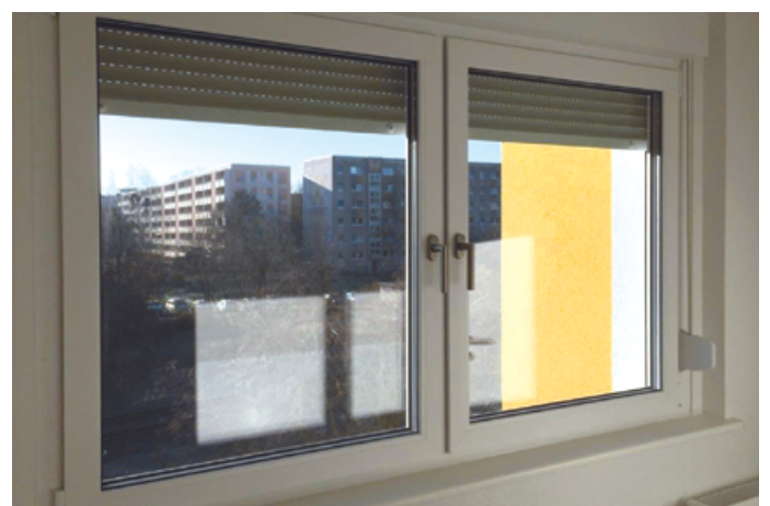
Abbildung 6: Oben: Darstellung der südlichen Fassade des Beispielobjektes mit Klappläden. Unten: Außenliegende Rollläden als Verbundbauteil mit den Fenstern.
