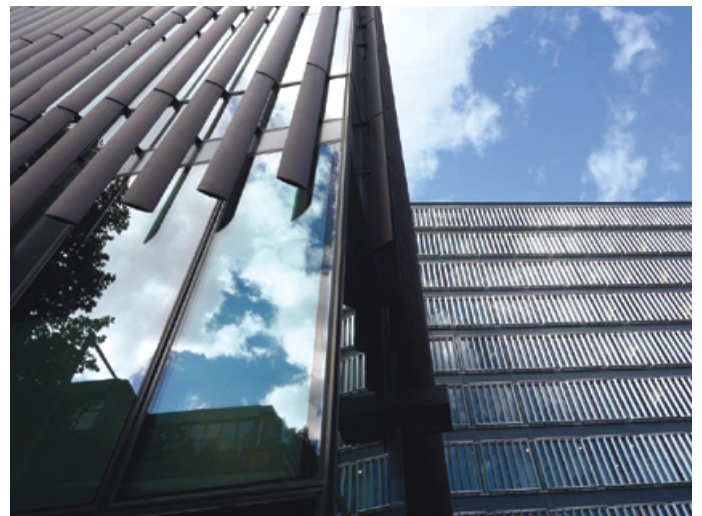
Abbildung 4: Verschattungsmöglichkeiten im Neubau: automatisch gesteuerte Raffstores (oben), feststehende Elemente zur Verschattung (unten)
