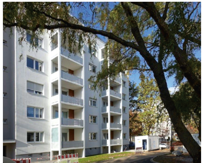
Abbildung 9: Ansicht der Fassade West eines noch unsanierten Beispielobjektes (oben) und der Fassade Ost eines sanierten Beispielobjektes mit zusätzlich vorgestellten Balkonen (unten).
